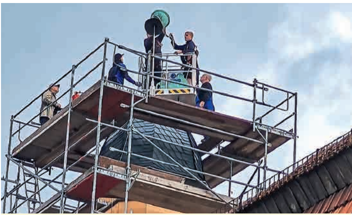
Wiederaufsetzen der Kugel auf den Turm vom Ratskeller.
