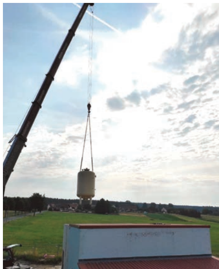
In das Wasserwerk Schönfeld wurden neue Filter eingehoben
