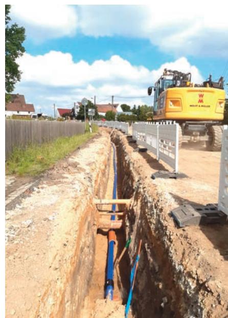
510 Meter neue Trinkwasserleitung wurden in Wildenhain innerhalb öffentlicher Verkehrswege verlegt.
