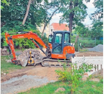
Die Sanierungsarbeiten am Zilledenkmal haben begonnen.
