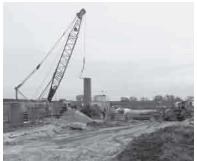
Ein Seilbagger im Einsatz bei den Kiesaustauschbohrungen. Foto: WRG
