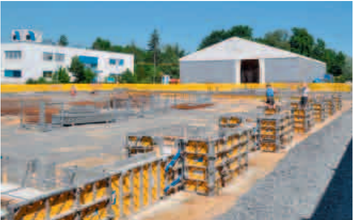
Schalungen für das Außenfundament
