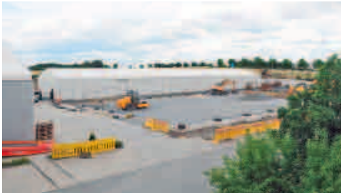
Planierwalze beim Verdichten des Schotters
