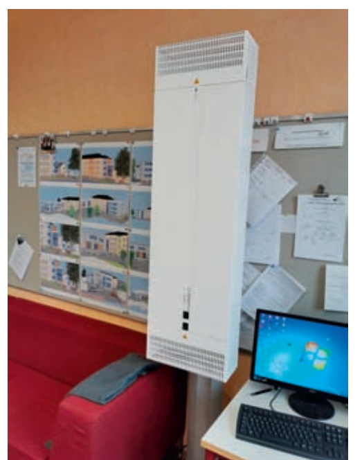
Der Luftreiniger „V-Lab300“ im Lehrerzimmer der Zilleschule in Radeburg.
