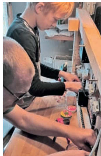
Mike und Dennis beim Verkabeln
