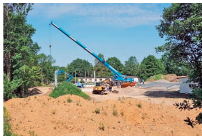
Baustelle an der Talsperrenmeisterei Radeburg
