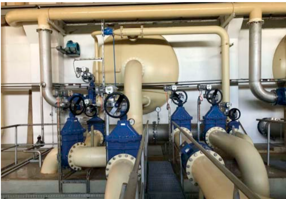
Die Filterarmaturen im Wasserwerk Fichtenberg werden erneuert.
