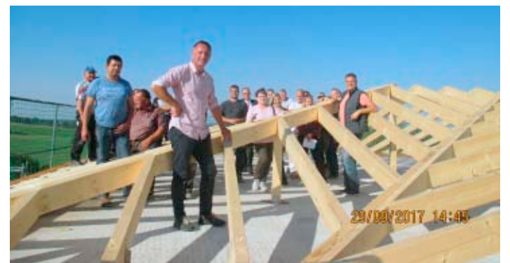
Die beiden Gesellschafter, René Eilke (vorn Mitte) und Jörg Fuhrmann (vorn links) begrüßten die geladenen Gäste. In einer kurzen Ansprache dankte René Eilke den am Bau Beteiligten, insbesondere der dieses Vorhaben unterstützenden Bank der Sparkasse Meißen, Frau Dipl.-Ing. Hertrampf vom Ingenieurbüro IGS als sowie den beteiligten Handwerkern.
