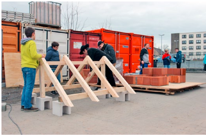
Dachstuhl und Mauerwerk entstehen unter fachkundiger Anleitung
